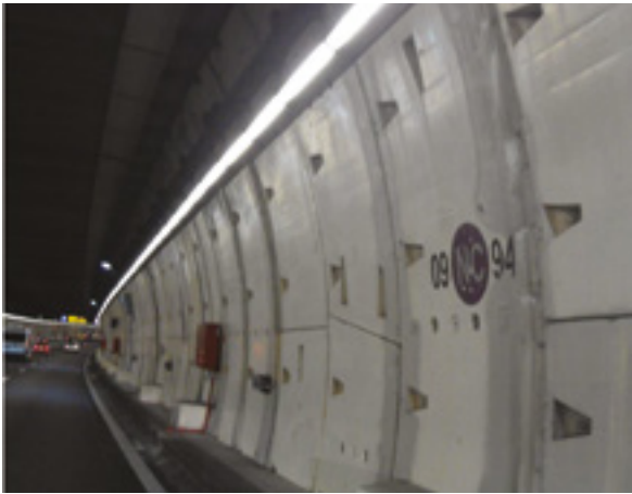
Ilustración 29 – Código alfanumérico del túnel M30-Bypass. En este caso el mismo código se encuentra en los hastiales de la galería de emergencia, situada justo debajo de la calzada.
